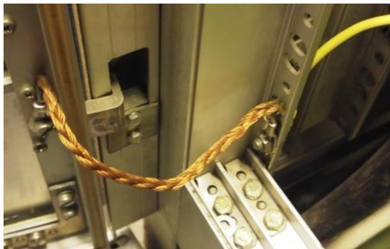
Példa a szekrényajtó földelő hálózatba való bekötésére
