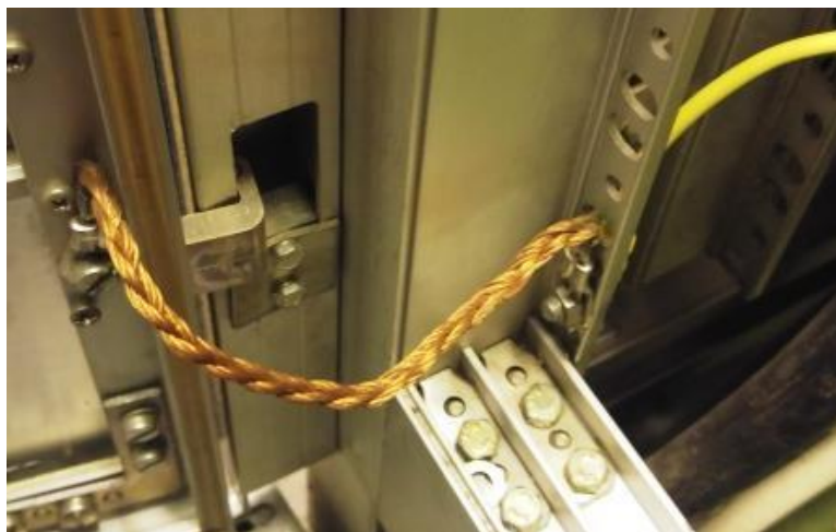
Példa a szekrényajtó földelő hálózatba való bekötésére
