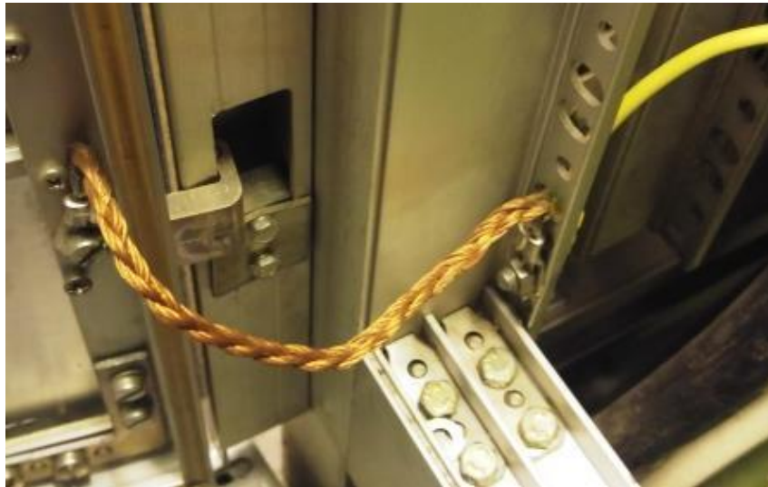
Példa a szekrényajtó földelő hálózatba való bekötésére
