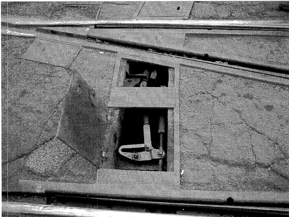
Nyomórugós váltóállító szerkezet átszelési kitérőben
