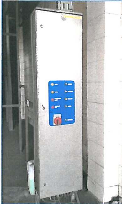
1/a. kép: gépi mosó vezérlő szekrénye
