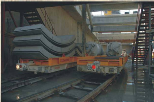
A vagon hat túbbinget szállíthat. A elemek három tonnánál is nagyobb súlyúak, és harminc centiméter vastagok. Egy ún. alagútgyűrűhöz hat túbbingre van szükség, ami másfél méteres „távolságot” jelent odalent.
