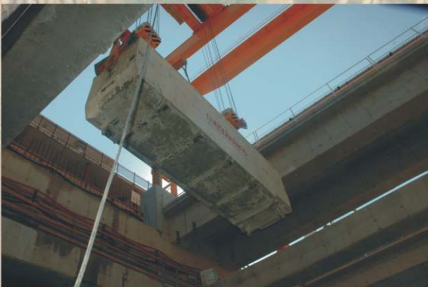
A szerelvény nem érkezik vissza üresen, hiszen a pajzs által fejtett földet szállítja kifelé. Egy kocsi 25 tonnányi földet bír el. Odakint daru segítségével emelik fel a „csillót”, s több méter magasan, a felszínen ürítik ki.
